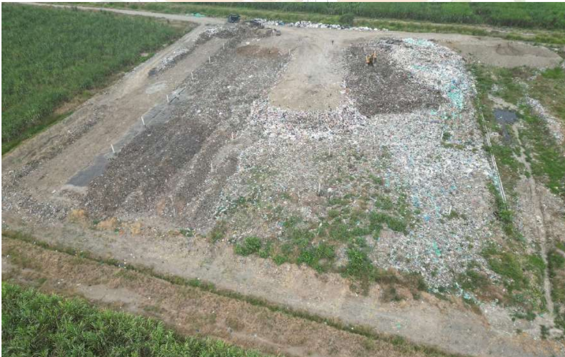
Construcción de celda emergente y operación de desechos sólidos
